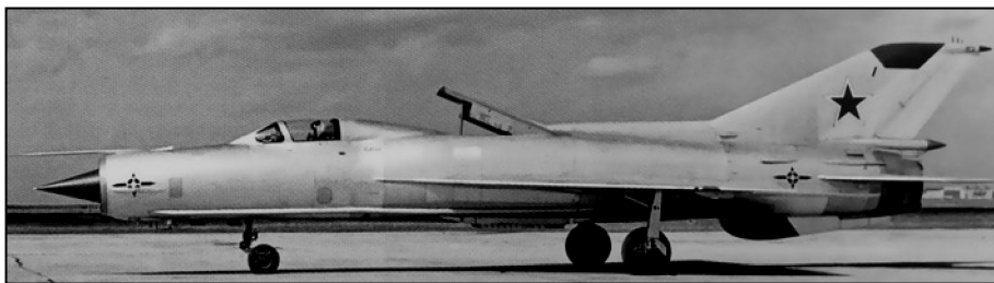
1966 : MiG-21PD , 用来测试用于 MiG23PD 的短距起降升力发动机
